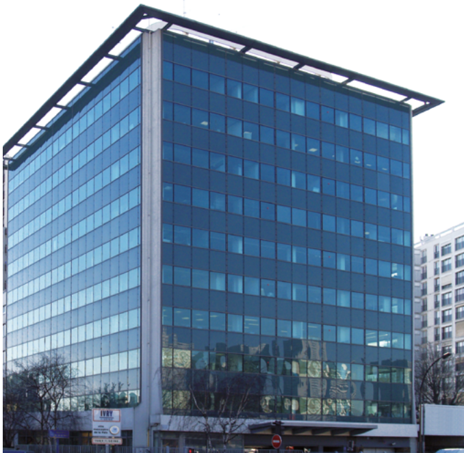
▲ 1, boulevard H. Marques - Ivry-sur-Seine (94)
