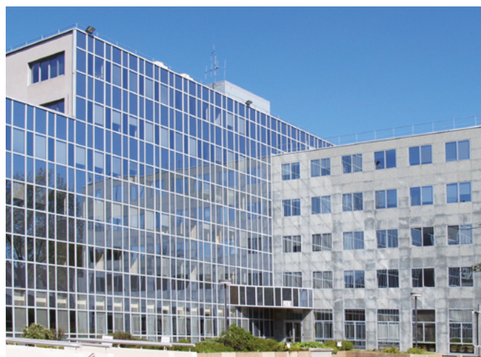
▼ 183, avenue Georges Clémenceau - Nanterre (92)
