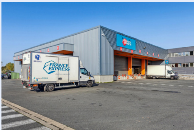
Rue Radio Londres - Bègles (33) - Acquisition du 1 er trimestre 2025
